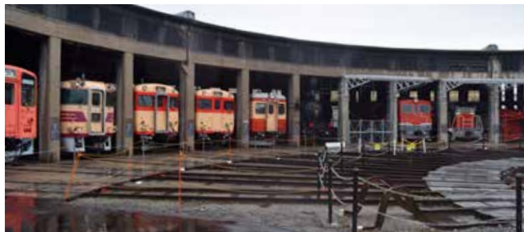
▲経済産業省の近代化産業遺産にも認定されている「旧津山扇形機関車庫」
